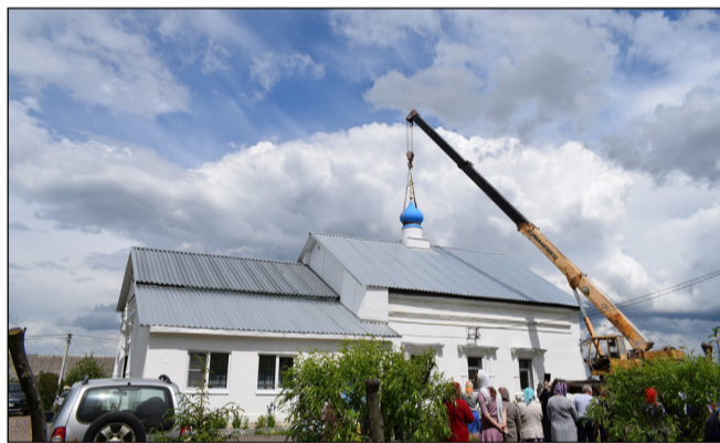
Установка главы и креста на кровлю Владимирского храма
